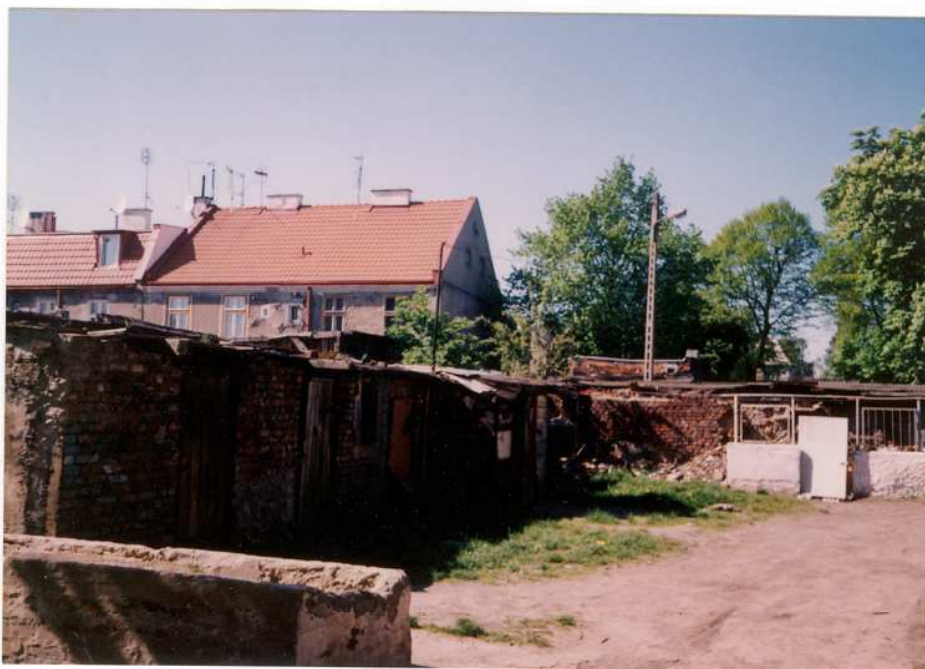
Fot. 7 Jedno z wielu podwórek oraz jego typowa zabudowa
