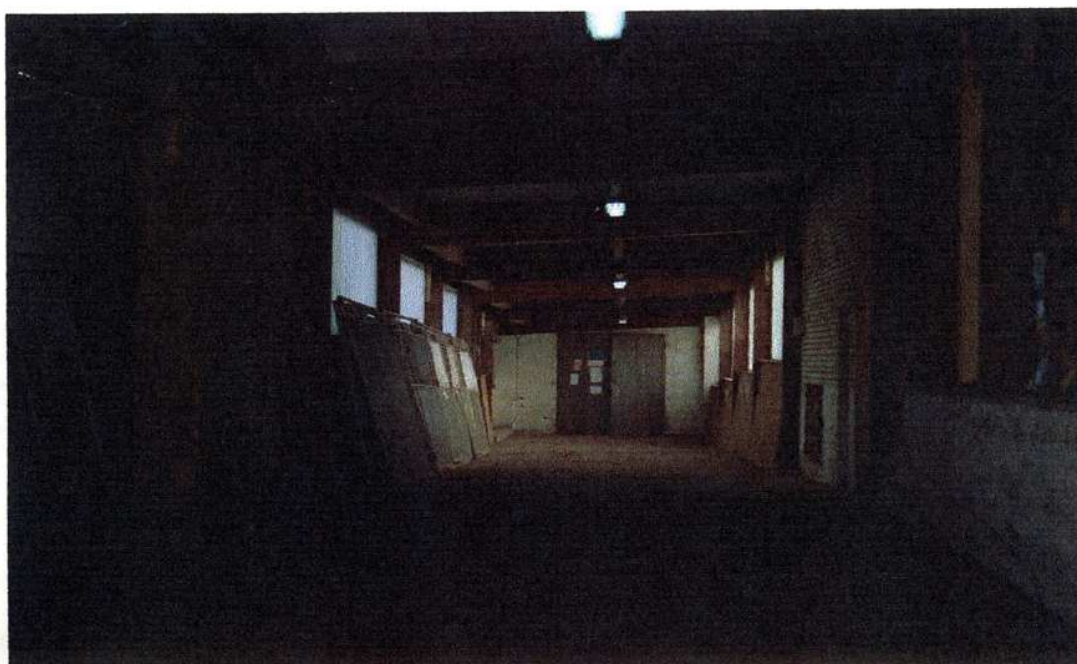
Łącznik, a w oddali wejście do głównej hali
