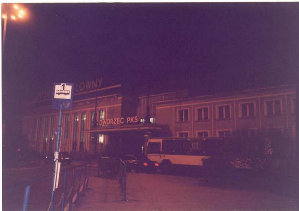
Fot.13 Plac przydworcowy oraz budynek objęty planem inwestycyjnym PKP
