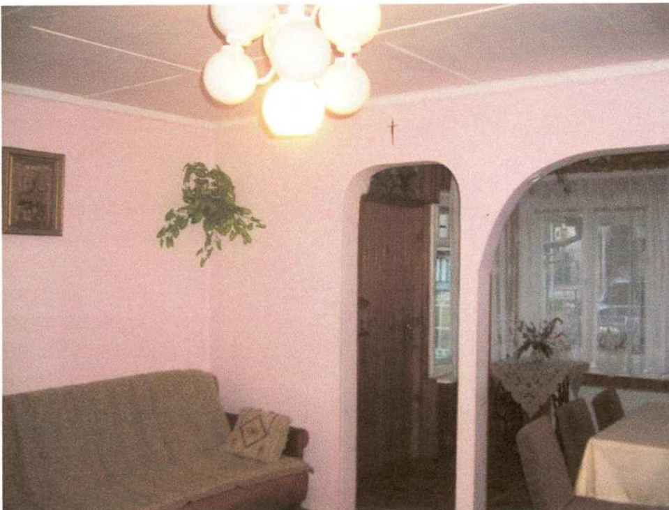
Ryc. 8. Wnętrze domu Państwa Y . Na suficie widoczne połączenia między płytami, z których zbudowany jest strop. Łukowate przejście między pomieszczeniami powstało przez demontaż fragmentu ściany.
