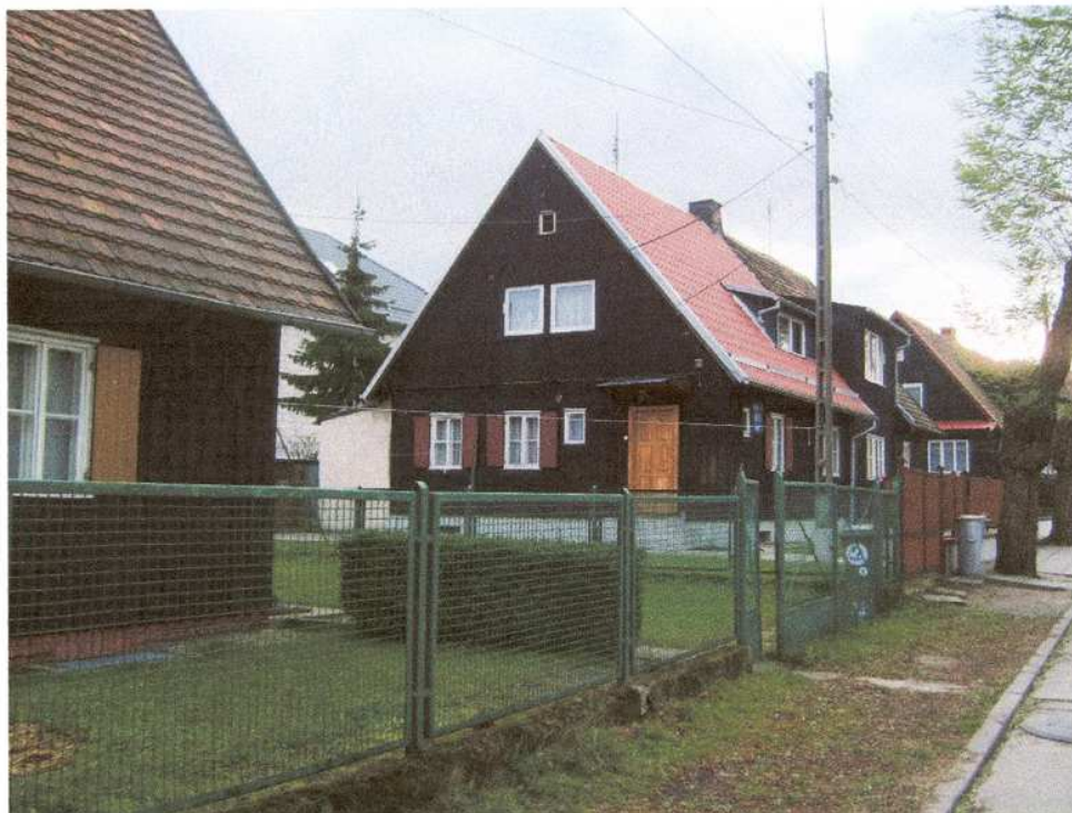
Ryc. 12. Jeden z domów należących do Administracji Budynków Mieszkalnych. Źródło: Fotografia ze zbiorów własnych
