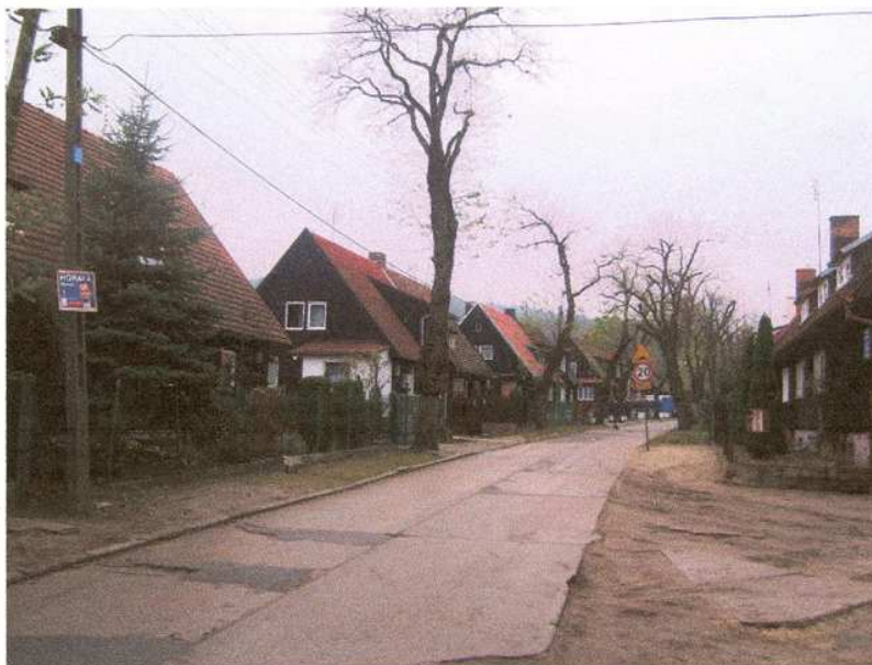
Ryc. 10. Brak chodników należy do podstawowych problemów ludności. Przy okazji można zauważyć, że betonowe płyty też mogłyby zostać wymienione. Źródło: Fotografia ze zbiorów własnych.
