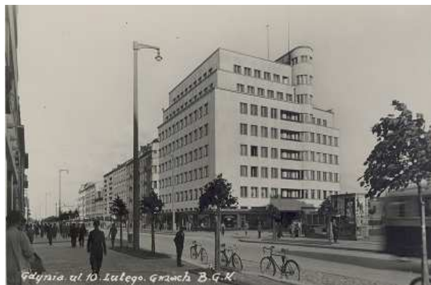
Ryc. 3. Pierwsza część budynku po zakończeniu, 1936 r.
