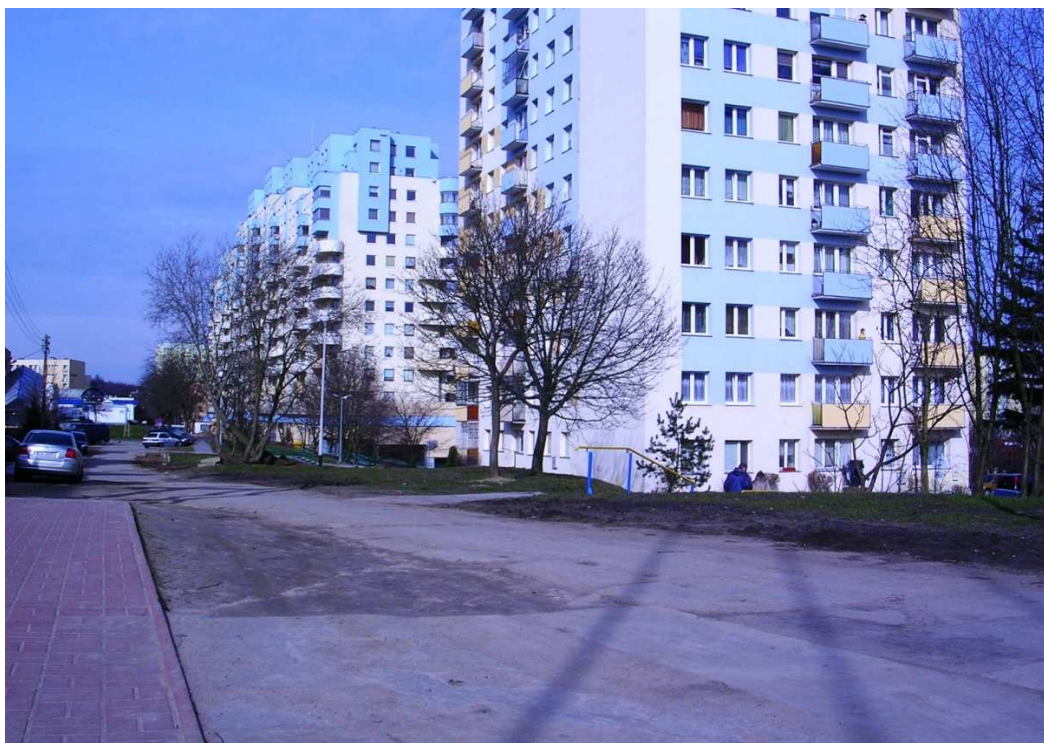
Zaplecze apartamentowca – nawierzchnia ulicy Niskiej
