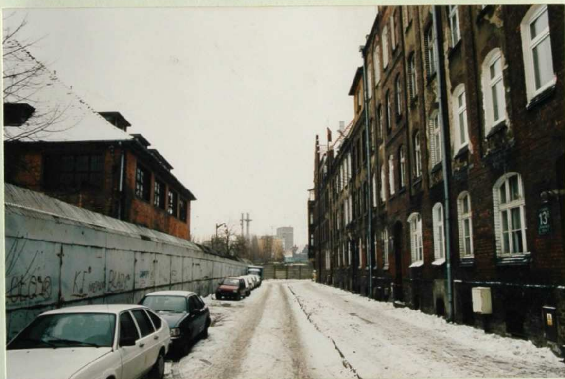
Zdjęcie 2. Widok budynków od strony ulicy Jaracz oraz tereny przystoczniovych
