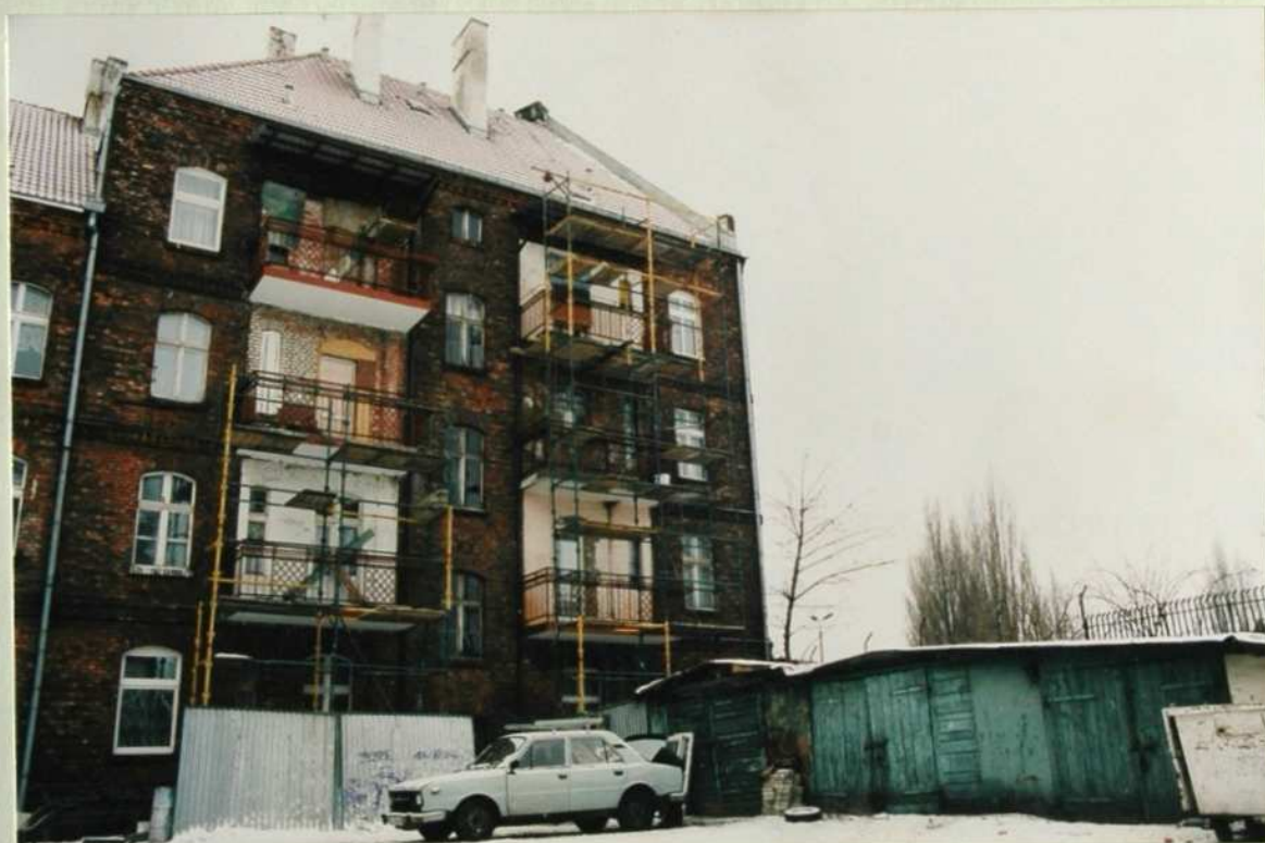
Zdj.3. Widok na garaże i remontowane balkony.
