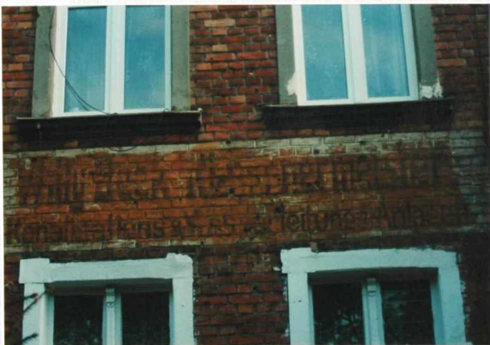
Ryc.9. Niedawno odkryty pod resztkami tynku szyld zakładu hydraulicznego.
