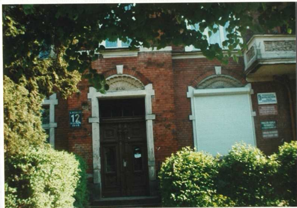
Ryc. 7. Fasada północna byłego hotelu przy Obrońców Westerplatte 12
