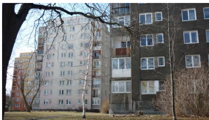
Trzy bloki mieszkalne nad kanałem
