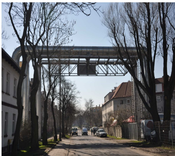
Rura ciepłownicza, w tle ulica Twarda
