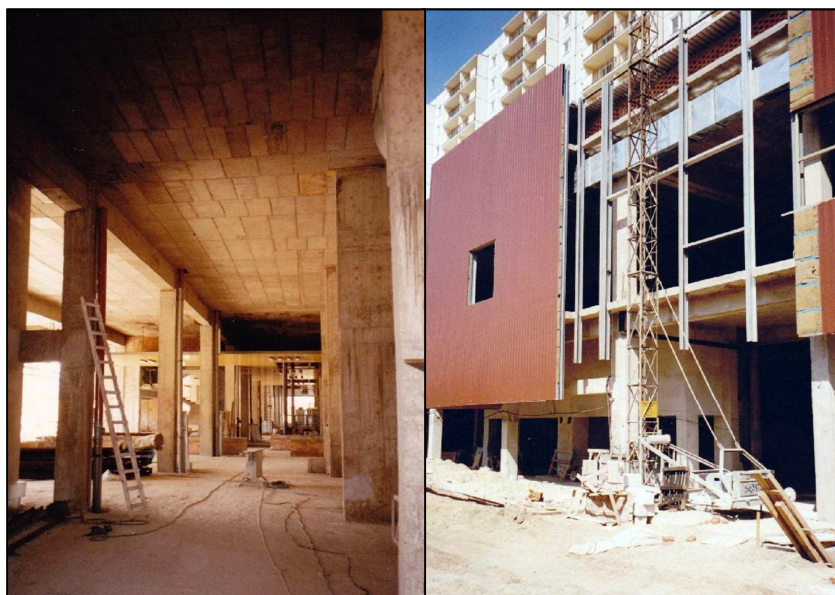
Fot. 1 Budowa DT Chylonia,
