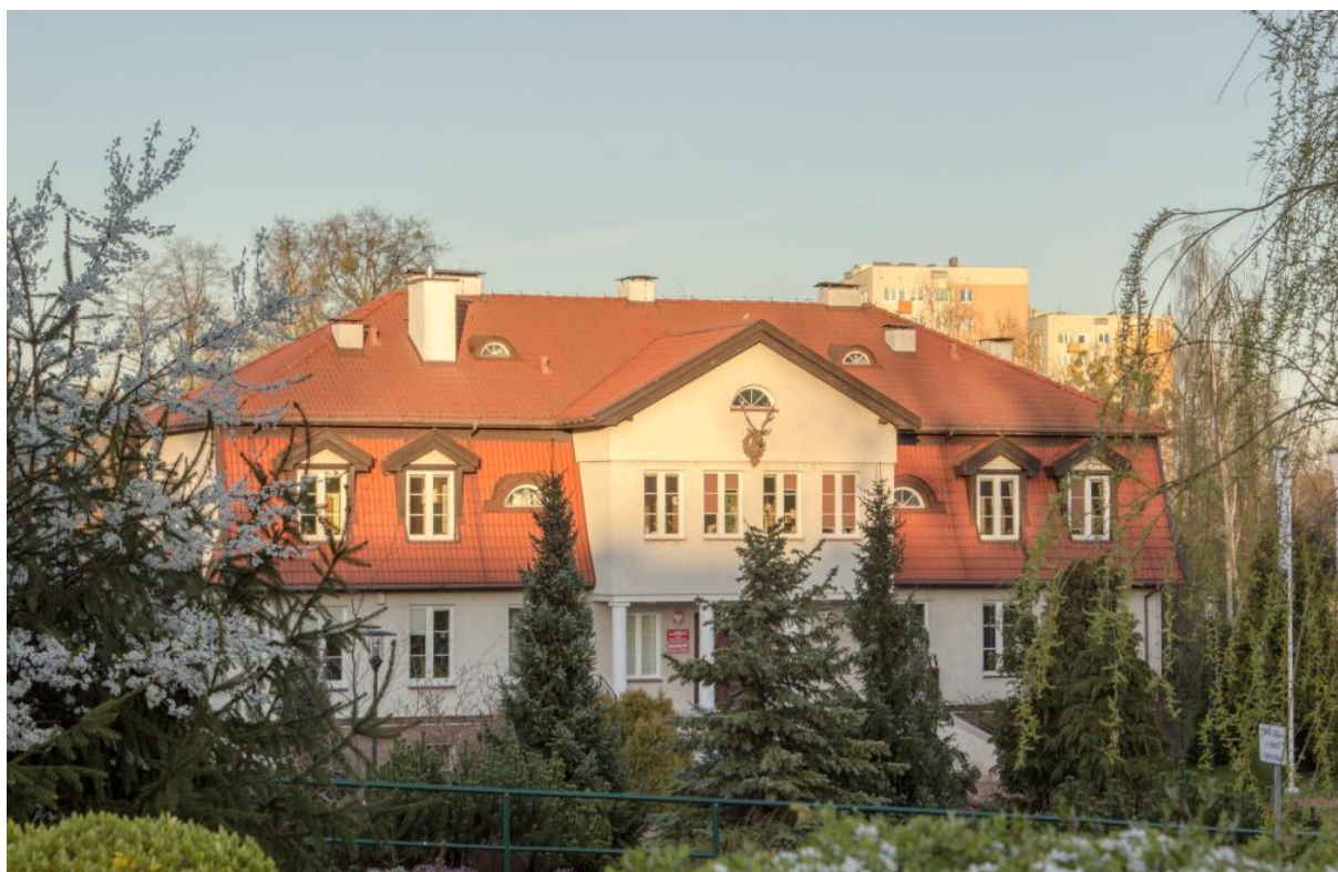
Fot. 17. Nowy budynek Nadleśnictwa Gdańsk z siedzibą w Gdyni.
