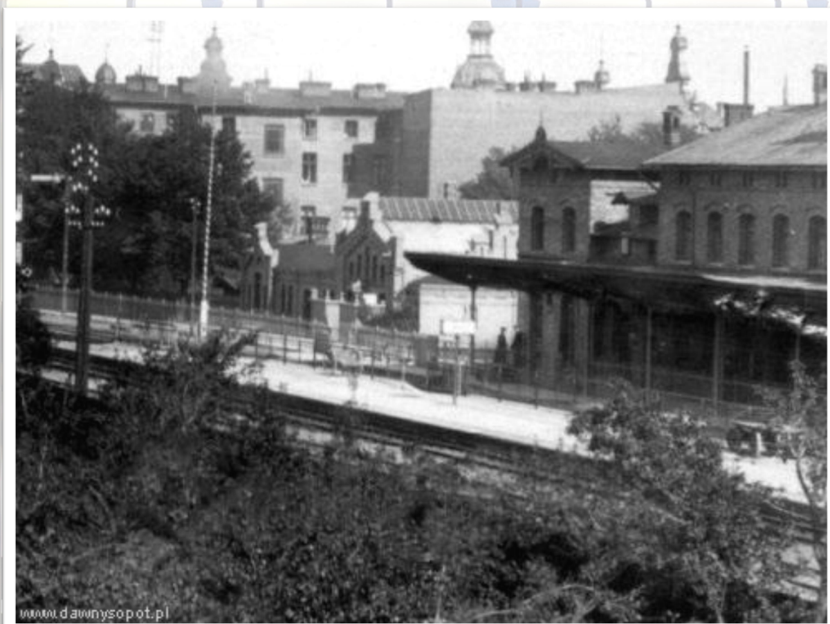
Rysunek 6 Budynek starego dworca z ok. 1900r. (fot. John Faltin)
