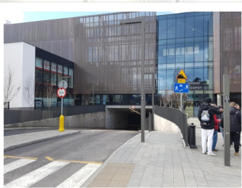
Rysunek 9 Wjazd do garażu podziemnego (fot. Adrian Ogrodowski)
