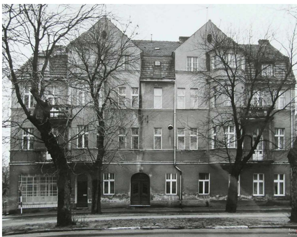
Fot. 1. Budynek przy ul. Cystersów 12 w listopadzie 1977 roku.
