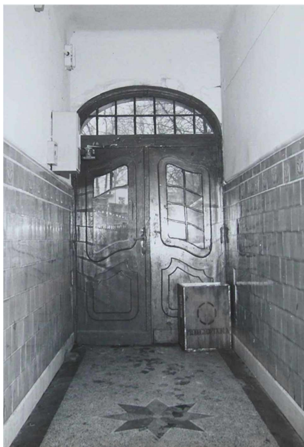
Fot. 2. Klatka wejściowa do kamienicy przy ul. Cystersów 12, listopad 1977.
