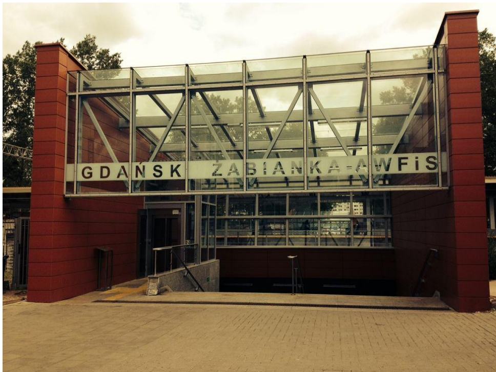
Fot. 29 Zmodernizowana stacja Żabianka SKM
