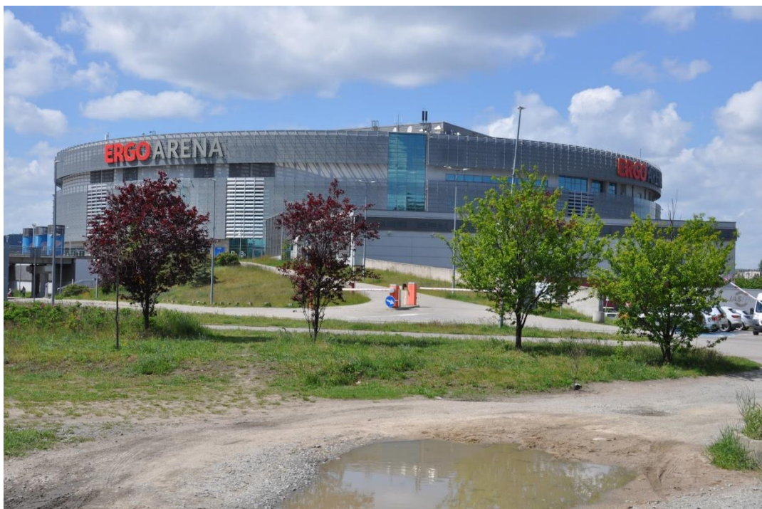
Fot. 20 Widok na Ergo Arenę z ulicy Gospody
