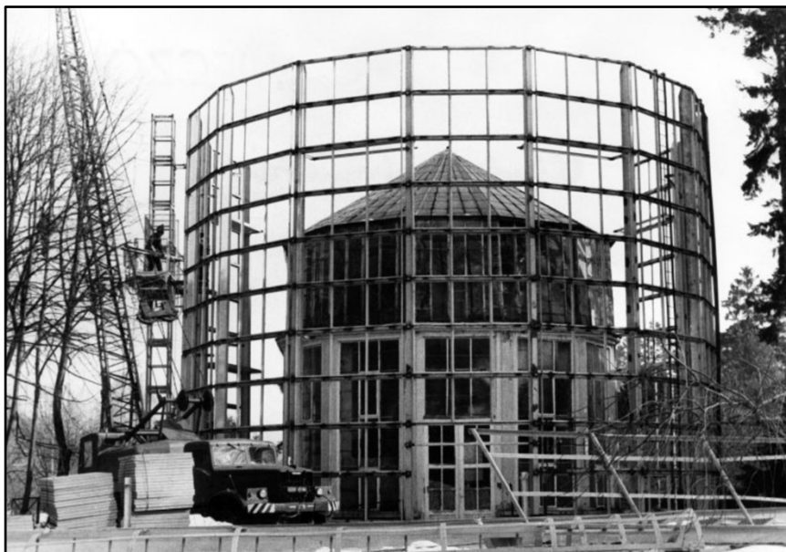
Ryc. 3. Budowa palmiarni rozpoczęła się w 1985 r. Źródło: Zbigniew Kosycarz
