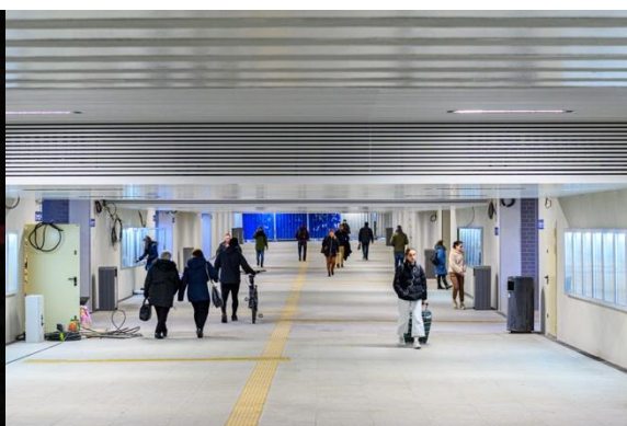
Przejście podziemne po przebudowie
